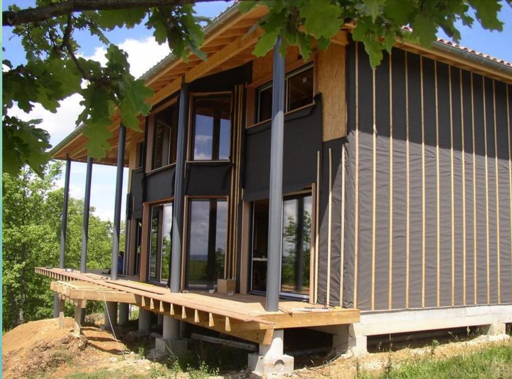
Il est préférable, dans la mesure du possible, de placer les colonnes principales à l'extérieur de l'ouvrage. Ceci permettra de protéger les colonnes et d'assurer une résistance au feu sur une durée très longue
