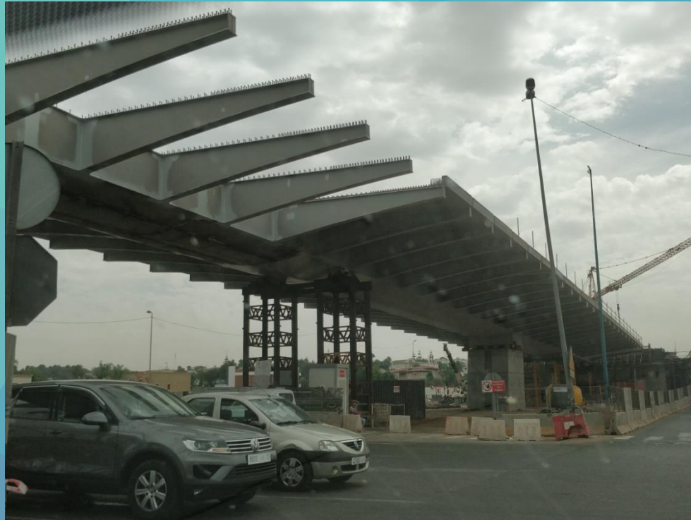
VIADUC Sidi Maarouf-Casablanca
