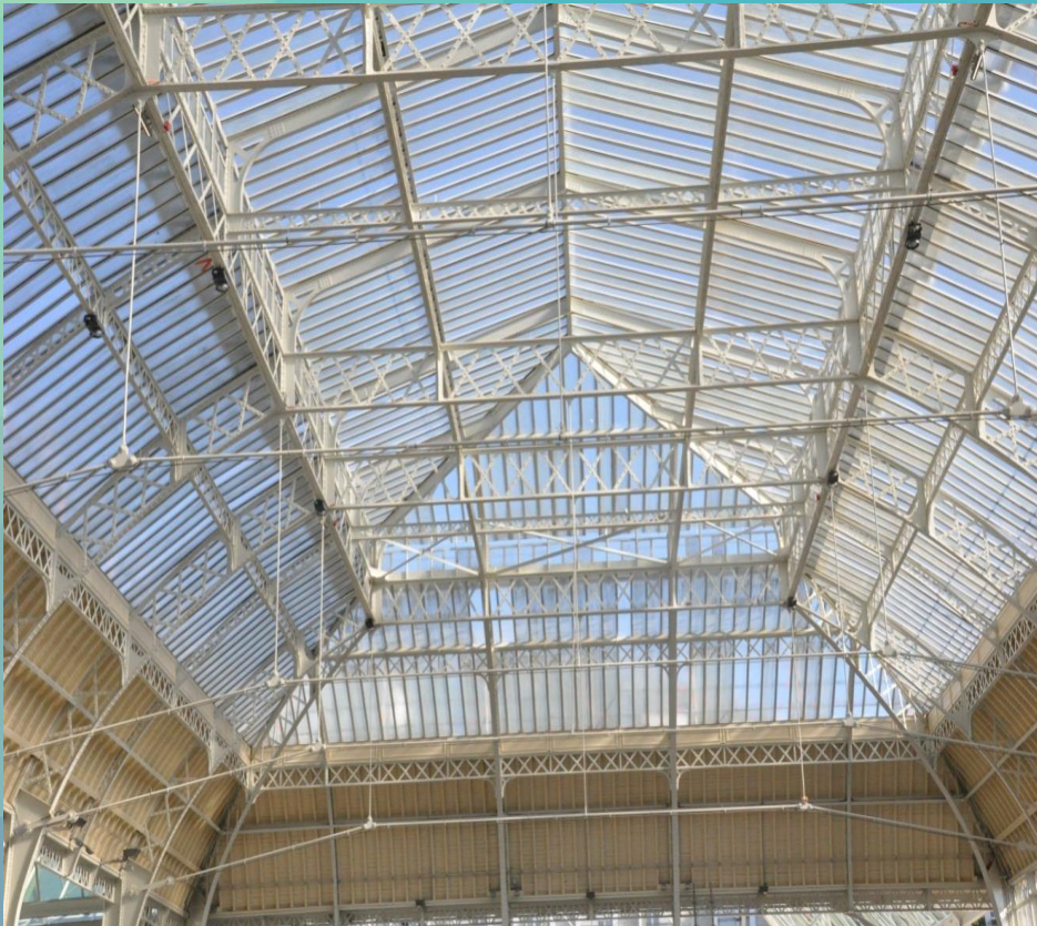
Verrières de la gare de Lyon(Paris) 35 X 60 m 170 t
