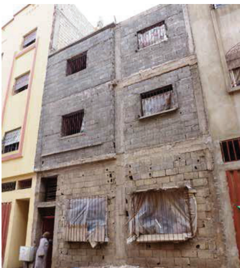
Fig. 7 : Le recasement (opération Essalam à Casablanca : surélévation, densité excessive et qualité architecturale médiocre
