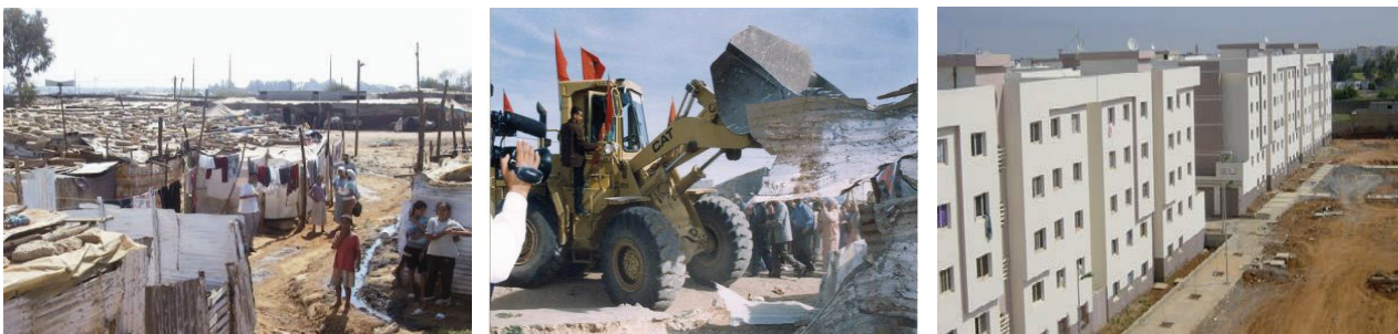
Fig. 3 : Processus type d'intervention dans un bidonville : démolition des baraques et relogement Source : Photos auteurs
